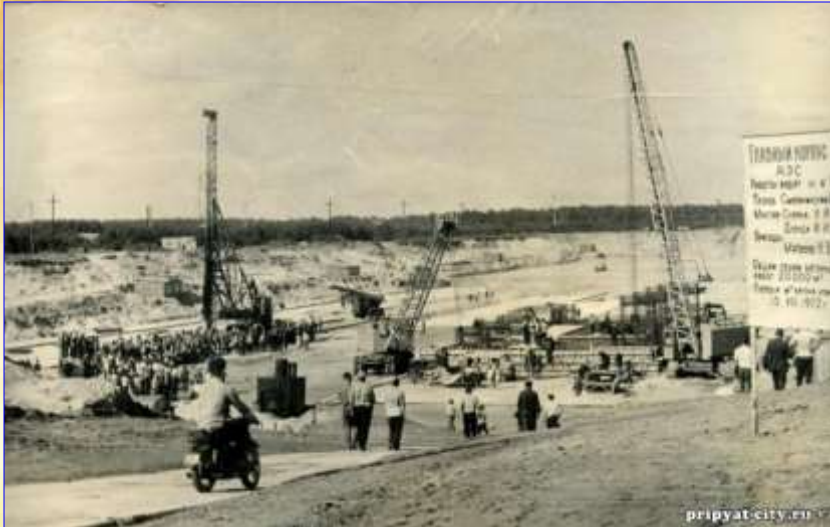
Будівництво Чорнобильської АЕС
