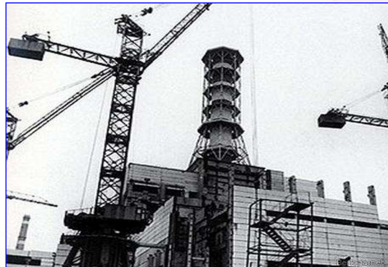
Монтаж верхніх перекриттів 4-го блоку ЧАЕС (1983)
