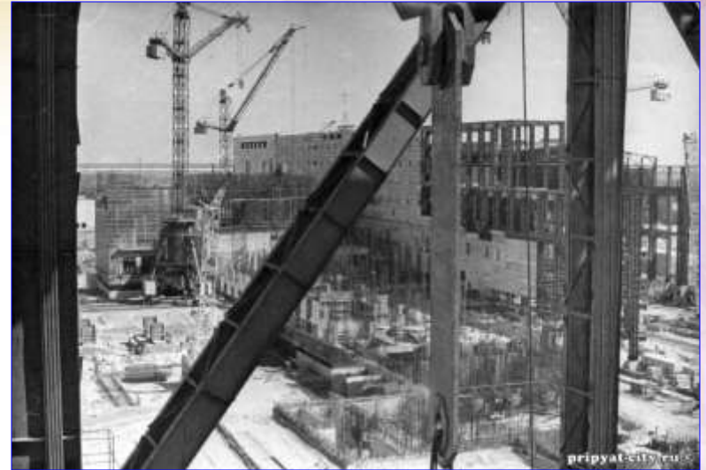
Вид з крану, який монтує реактор
